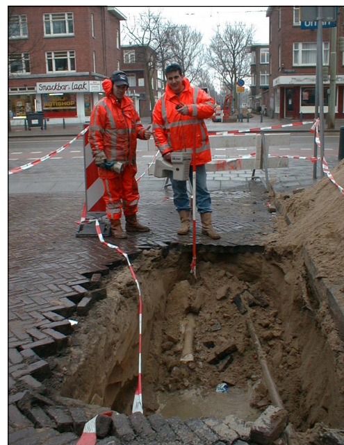
Gert Kramer (links) von Kadam b.v. mit Bohrgerät am Ausgangsschacht auf der Arbeitsstelle in den Niederlanden
