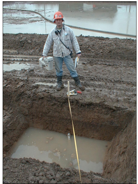
Jaap den Hollander von Visser & Smit Hanab b.v. am Ausgangsschacht bei der Arbeit in Holland
